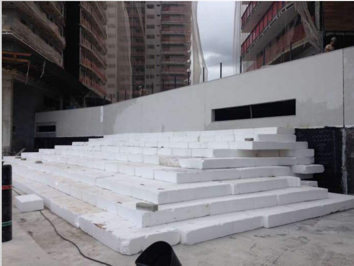
Montagem do EPS
