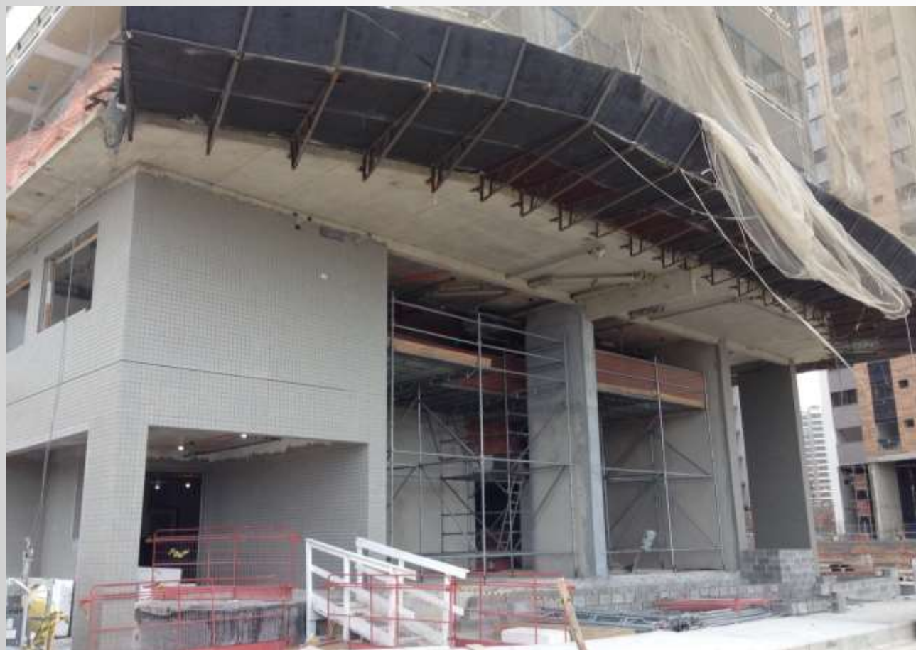
Início de execução
